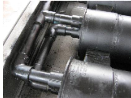
Se presentó el problema de fijar el cople a la tapa de tubo de PVC de 4 pulgadas, de tal manera que fuese lo suficientemente resistente, aislado y maleable. Hicimos varias pruebas y la que nos pareció más adecuada fue la consistente en utilizar un cople cuerda exterior fijado con una contratuerca y sellado con un empaque. Hasta la fecha ha funcionado bien.
